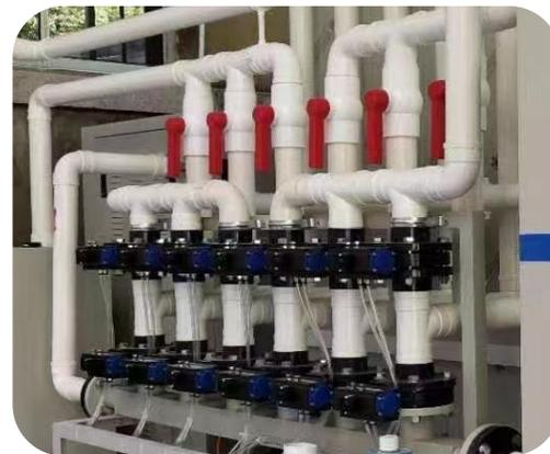
库气调节站为气调库的配套设备，它将若干库房的管路汇集于一处，使之与我公司生产的果蔬降氧机、二氧化碳脱除机、乙烯脱除机设备相连，便于用户使用统一管理，外形美观调节站可大大减少现场施工的时间及复杂度，更好的保证阀门组间的**良好气密性**。
